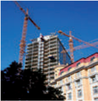
Hotel Prater (Sofitel) Wenen in aanbouw.
